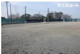
水はけが悪く、クレイコートの表層砂を補充しても路盤が現れている状態
