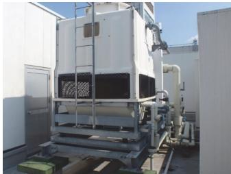
②講義棟吸収式冷温水ユニット内の老朽による漏洩
