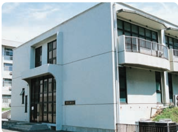
情報処理センター Information Processing Center
